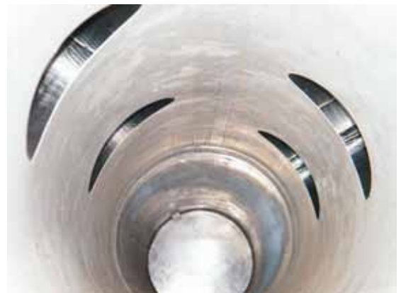
Blick vom Kontrollschacht in das Kanalrohr:
