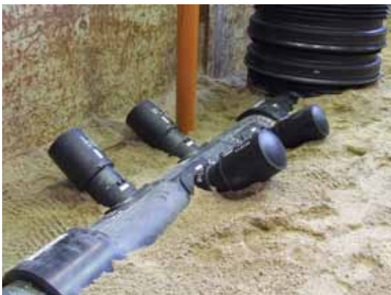
Detail des Versuchsaufbaus mit vier FRIAFIT- Abwassersätteln vor der Überschüttung
