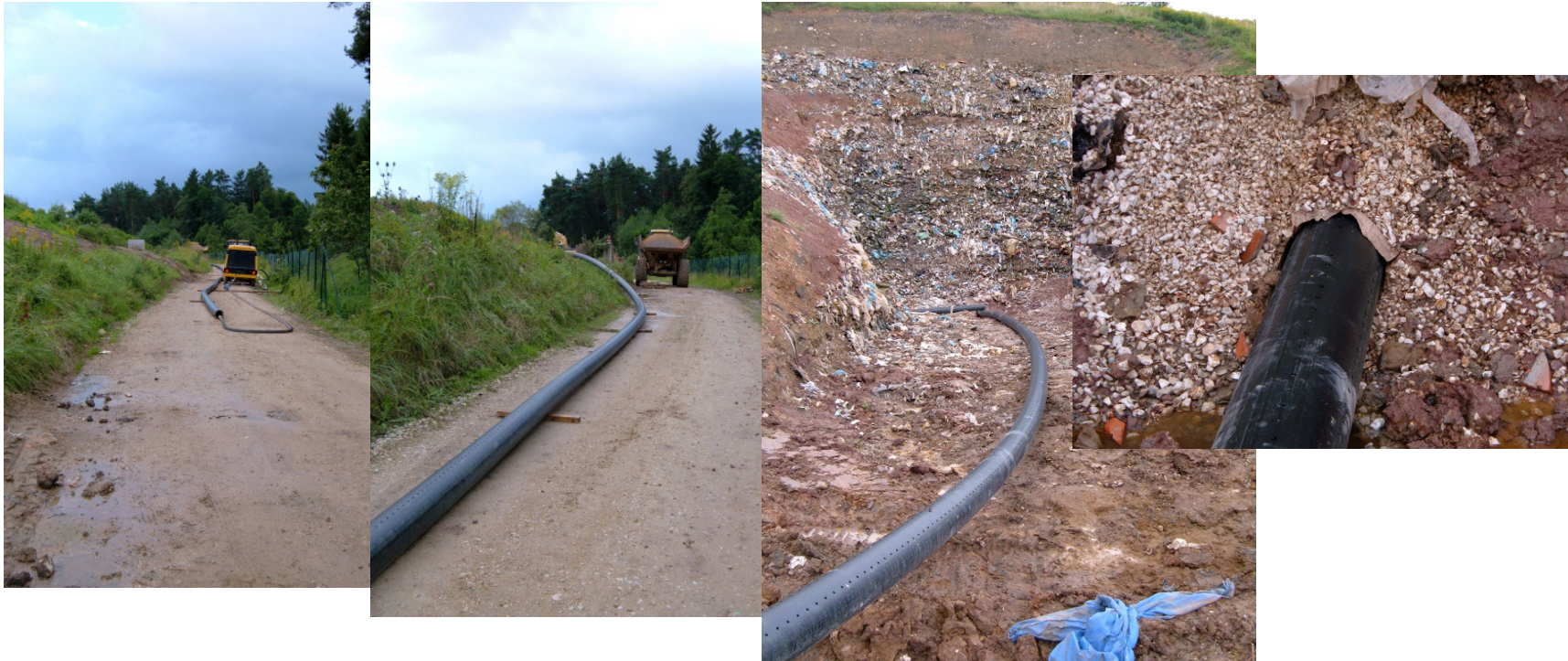
Einziehen eines Rohrstranges
